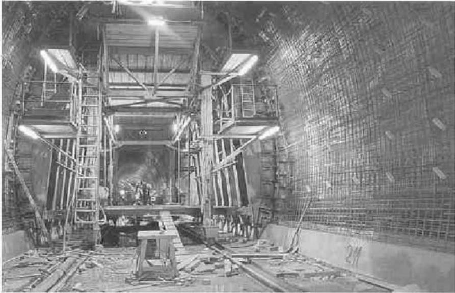
**Fig. 5.31.** Rolling formwork (Nebenwegtunnel, Vaihingen/Enz) <sup>27</sup>
