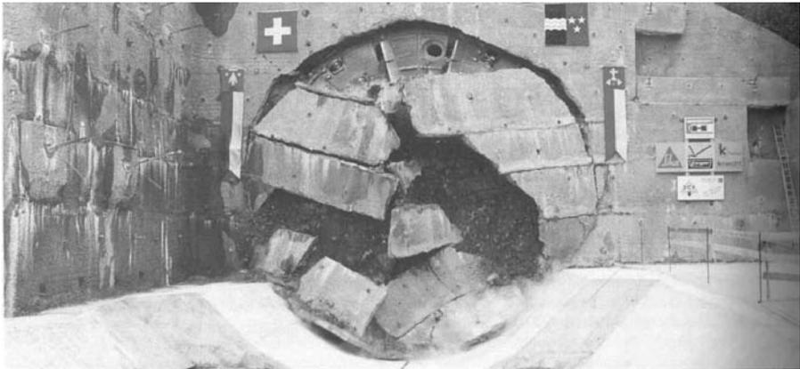
**Fig. 4.51.** TBM breakthrough<sup>48</sup>
