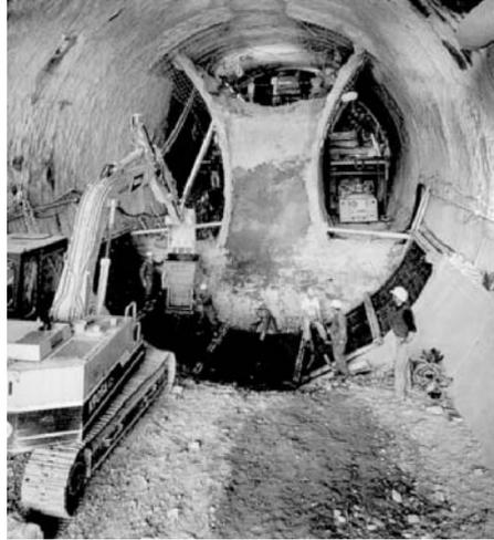
Fig. 4.8. Sidewall drift<sup>4</sup>
