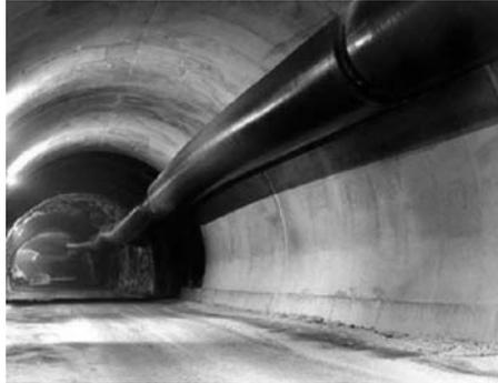
Fig. 2.1. Ventilation ducting<sup>6</sup>
