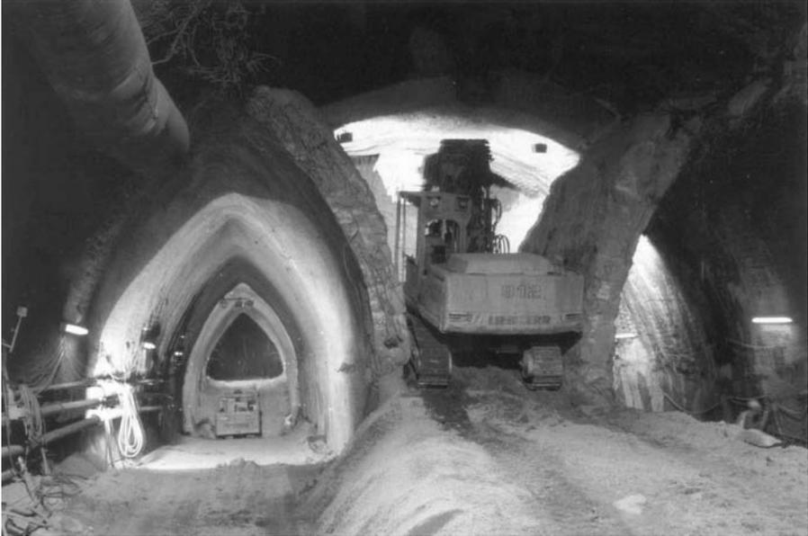
**Fig. 4.10.** Niedernhausen tunnel, sidewall drift<sup>5</sup>
