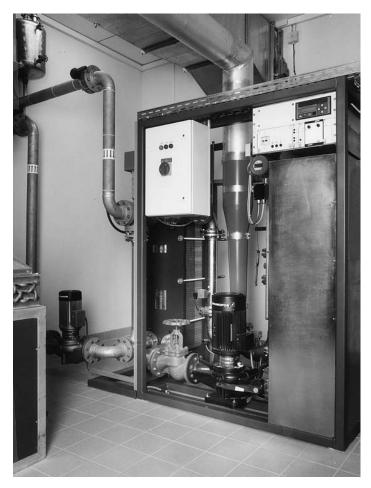
**Figure 2.3** Telefunken dummy load (Courtesy Telefunken Sendertechnik GmbH)
